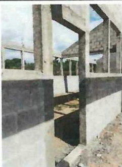
Foto 3: Se necesita instalar puertas para aulas debido a que no existen actualmente en el establecimiento.
